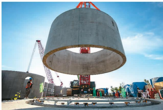
日前，安徽省亳州市谯城区160米风力发电机混塔开始吊装。该项目共计20台，每台装机容量5兆瓦，建成后将助力改善生态环境，减少碳排放，推动地方经济发展。图为在谯城区双沟镇周大村，施工人员吊装风力发电机混塔。
