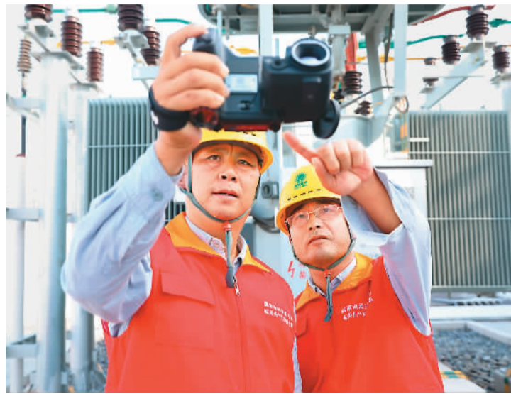
日前，国网安徽省电力有限公司濉溪县供电公司员工利用5G通信、智能巡检机器人，对安徽省首个“5G+源网荷储”新一代变电站示范工程——35千伏谭家变电站设备进行调试和巡检。谭家变电站工程投运后，将提高濉溪县电网迎峰度夏能力，助力当地经济社会发展。
