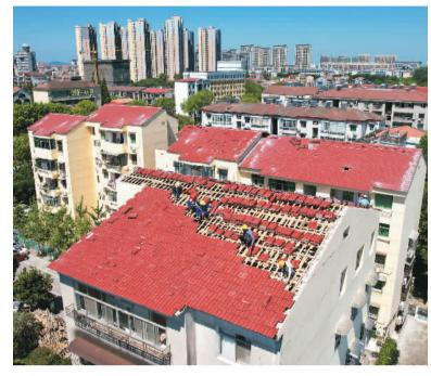
近年来,湖北省宜城市加快老旧小区改造,将全市233个老旧小区纳 入五年改造计划,着力解决老旧小区设施不完善、环境脏乱差、物业管 理混乱等问题。图为8月6日,工人们在给小区楼顶更换新瓦。
