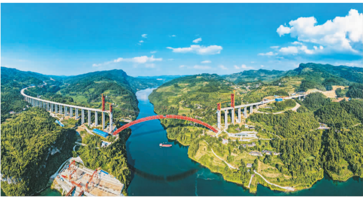
位于贵州省思南、石阡、凤冈三县交界处的德(江)余(庆)高速乌江特大桥目前建设正酣。该项目是德余高速控制性工程,全长1834米,主桥为504米上承式钢管混凝土拱桥。图为8月2日,大桥主拱圈正在进行最后的吊装施工。邓刚摄(人民图片)
