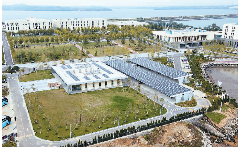
山东省荣成市石岛管理区“国和一号+”智慧核能综合利用示范项目一期崂山光伏项目。
