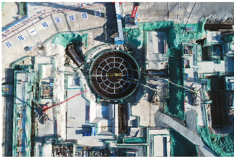
2021年7月13日，“玲龙一号”陆上商用模块化小型反应堆在海南省昌江黎族自治县开工。
