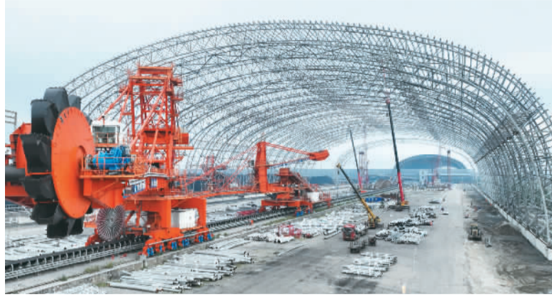
近日，河北省唐山曹妃甸港区煤码头三期工程后续建设项目封闭式煤炭堆场条形储备仓建设正在稳步推进。该储备仓储备设计能力93万吨，是曹妃甸港区推进煤尘抑制、减少污染的重要环保设施。图为建设工地施工现场。新华社记者 杨世尧摄
