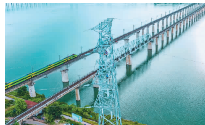
为配合四川省重点建设项目南充市将军路嘉陵江大桥新建工程建设，国网南充供电公司加紧实施110千伏望郊线、望荆线线路迁改工程。图为供电员工在85米高的新建铁塔上开展架线作业。 安伟摄（人民视觉）
