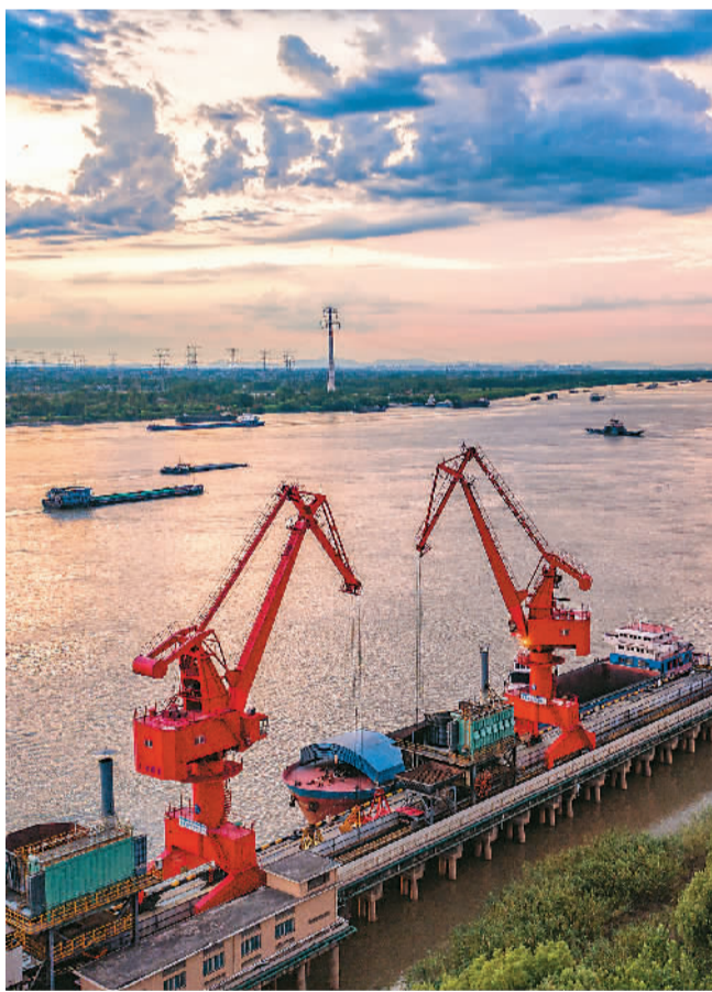
安徽省芜湖市繁昌区近年来积极推进内河水运发展，降低企业运输成本，为融入长江经济带高质量发展提供助力。图为七月二十六日傍晚，该区荻港段码头上的起重设备正在进行装卸作业。 肖本祥摄(人民视觉)
