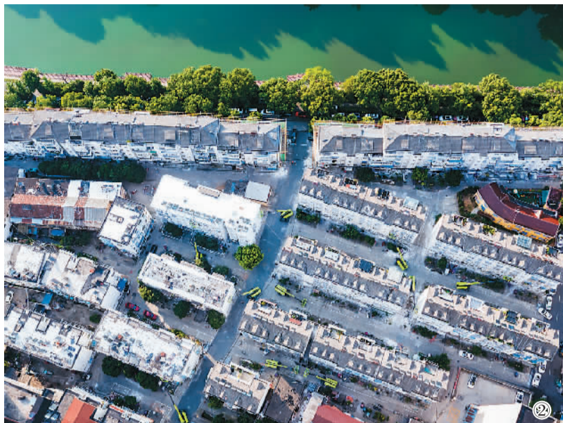
图①：1月17日，在江苏省常州市武进区凤翔工业园厂房拍摄的屋顶光伏电站。 胡平摄（人民视觉）
