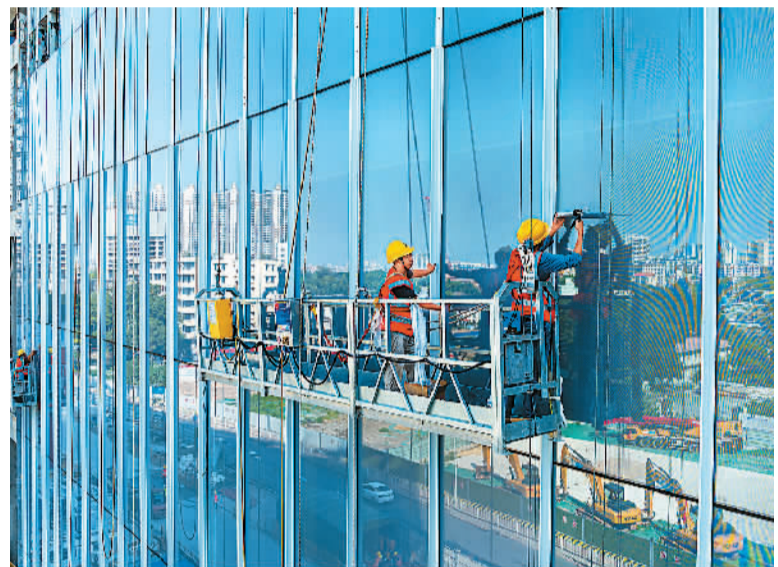
广东美术馆新馆、广东非物质文化遗产展示中心、广东文学馆“三馆合一”项目是广东省重大标志性公共文化设施，目前已全面封顶，进入幕墙施工及装饰装修施工阶段。图为7月24日，建设者正在安装玻璃幕墙。
