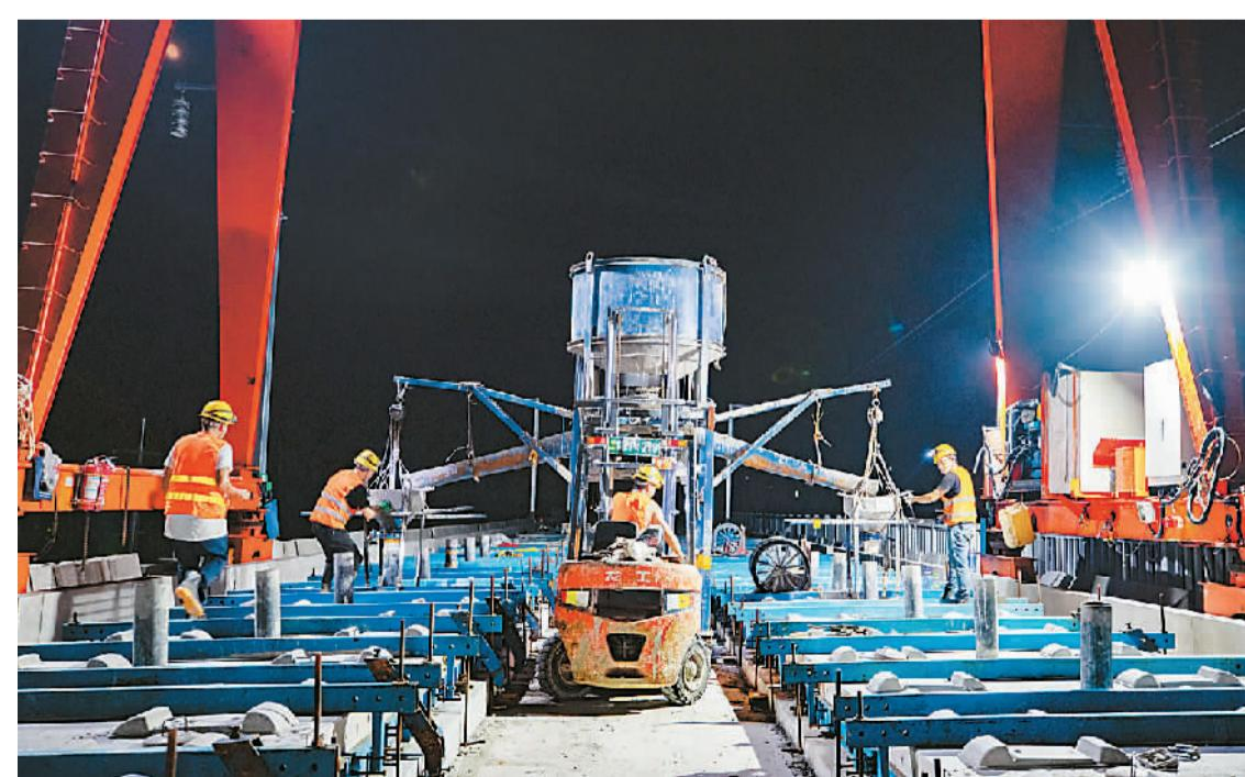
7月17日，由中铁上海工程局承建的南沿江城际铁路太仓段，率先在全线完成无砟轨道施工任务，为后续铺轨贯通和通车运营创造了有利条件。新建南沿江城际铁路西起南京南站，东至太仓站，正线全长278.53公里，设计时速350公里，是长三角铁路网的重要组成部分。图为南沿江城际铁路江苏省太仓市境内七浦塘特大桥施工现场，建设者正在浇筑无砟轨道板混凝土。
