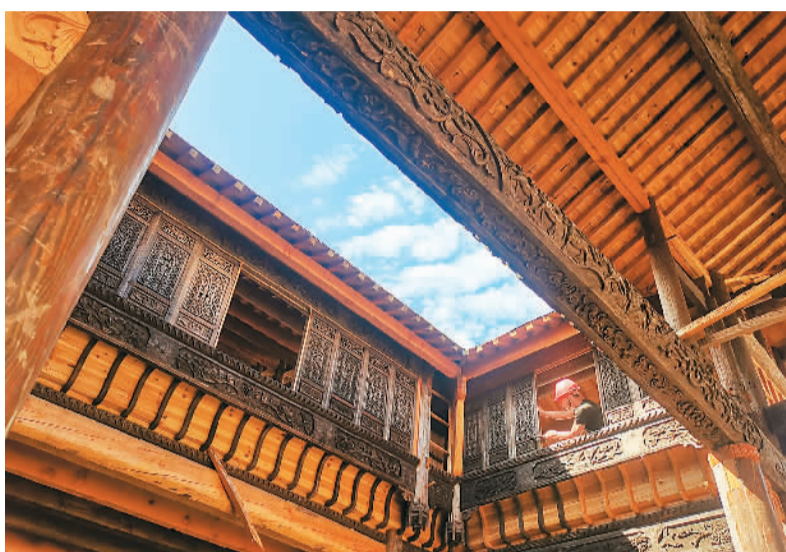
湖北省孝感市云梦县在吴铺镇集中归类复原一批特色古建筑,让文化在城市融合发展,传承好古建筑文化艺术。图为近日,在吴铺镇祥云湾古建筑修复工地,工匠正在作业。 胡学军摄(人民视觉)
