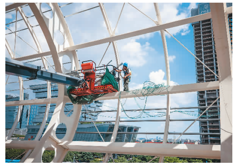
位于广东省广州市海珠区的广交会展馆四期扩建项目总建筑面积约56万平方米，建成后新增展位6000多个，是广交会展馆建设史上规模最大的扩建项目。目前，展厅、会议中心及东登展厅、西登展厅土建主体结构已封顶。图为7月8日，建设者正在进行展馆的钢结构涂漆涂装作业。
