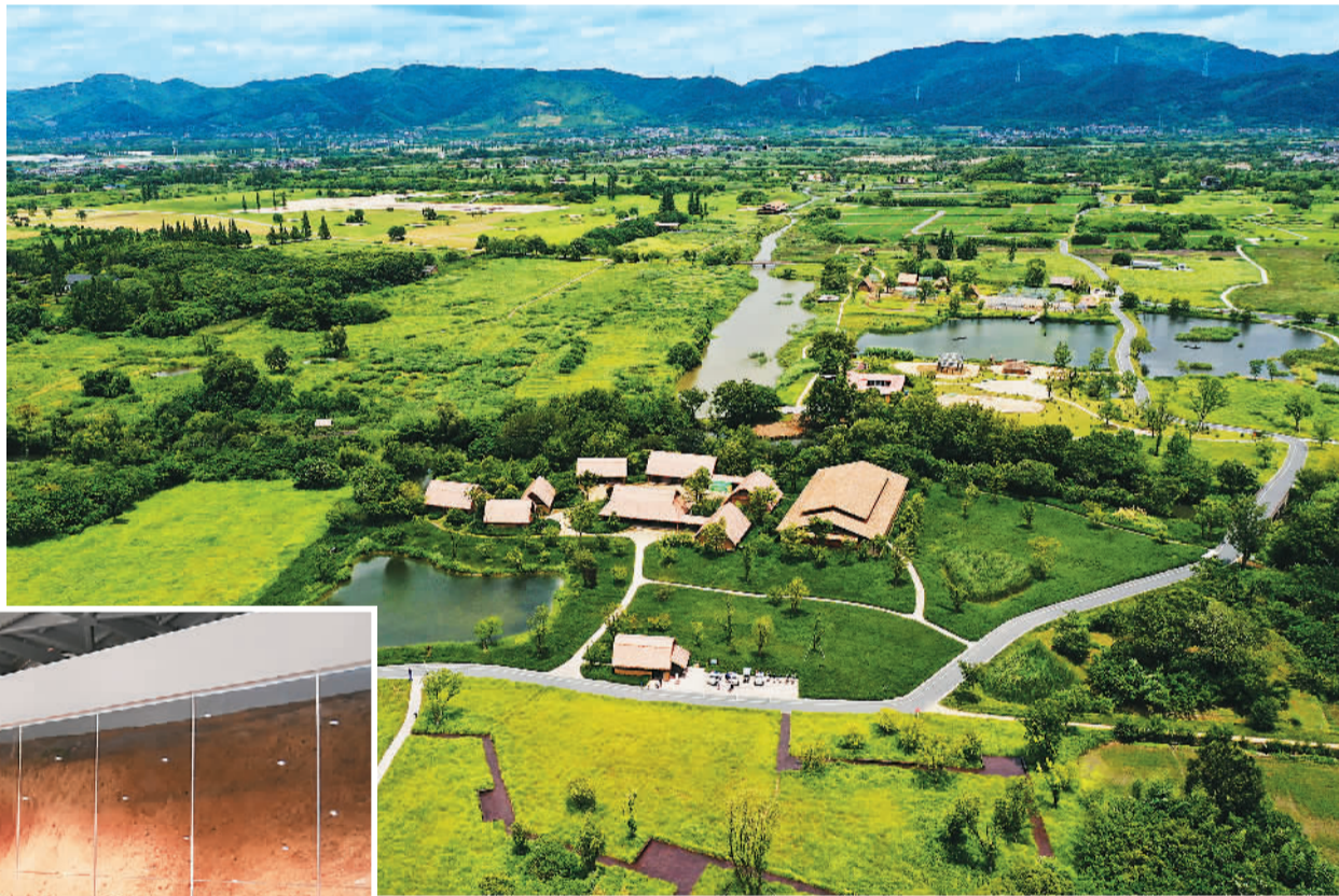
良渚古城外围水利系统的影响范围约100平方公里,由谷口高坝、平原低坝和山前长堤等11条人工坝体和天然山体、溢洪道构成,是中国迄今发现最早的大型水利系统。
