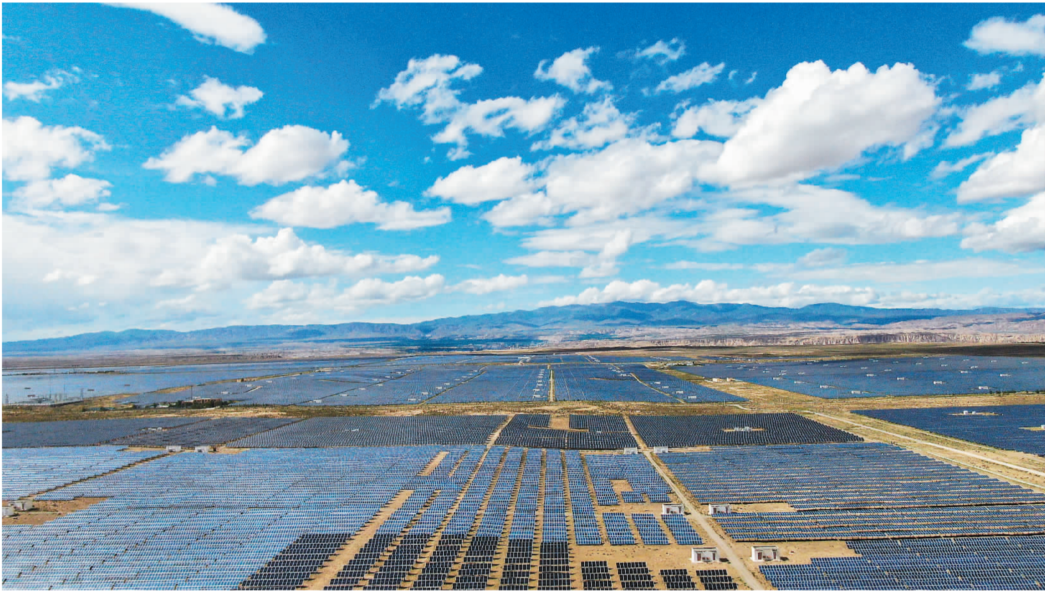
6月26日，无人机拍摄的青海省海南藏族自治州共和县光伏电站。
