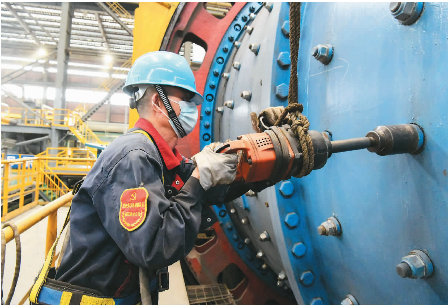
◀ 4月27日,在安徽铜陵有色金冠铜业公司选矿车间,铜陵有色铜冠建筑安装公司党员突击队在维修溢流型大型半自磨机。 过仕宁摄(人民视觉)
