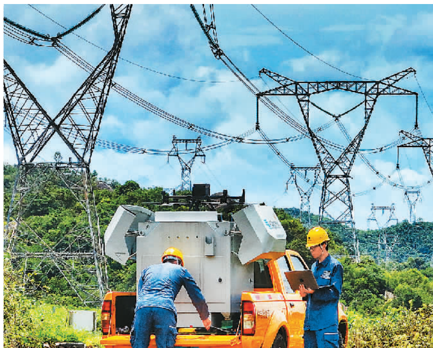
图为南方电网深圳供电局输电线路运维人员利用车载移动机架起飞无人机对对港供电线路400千伏核深线进行特巡特维。李志杰摄(人民视觉)
