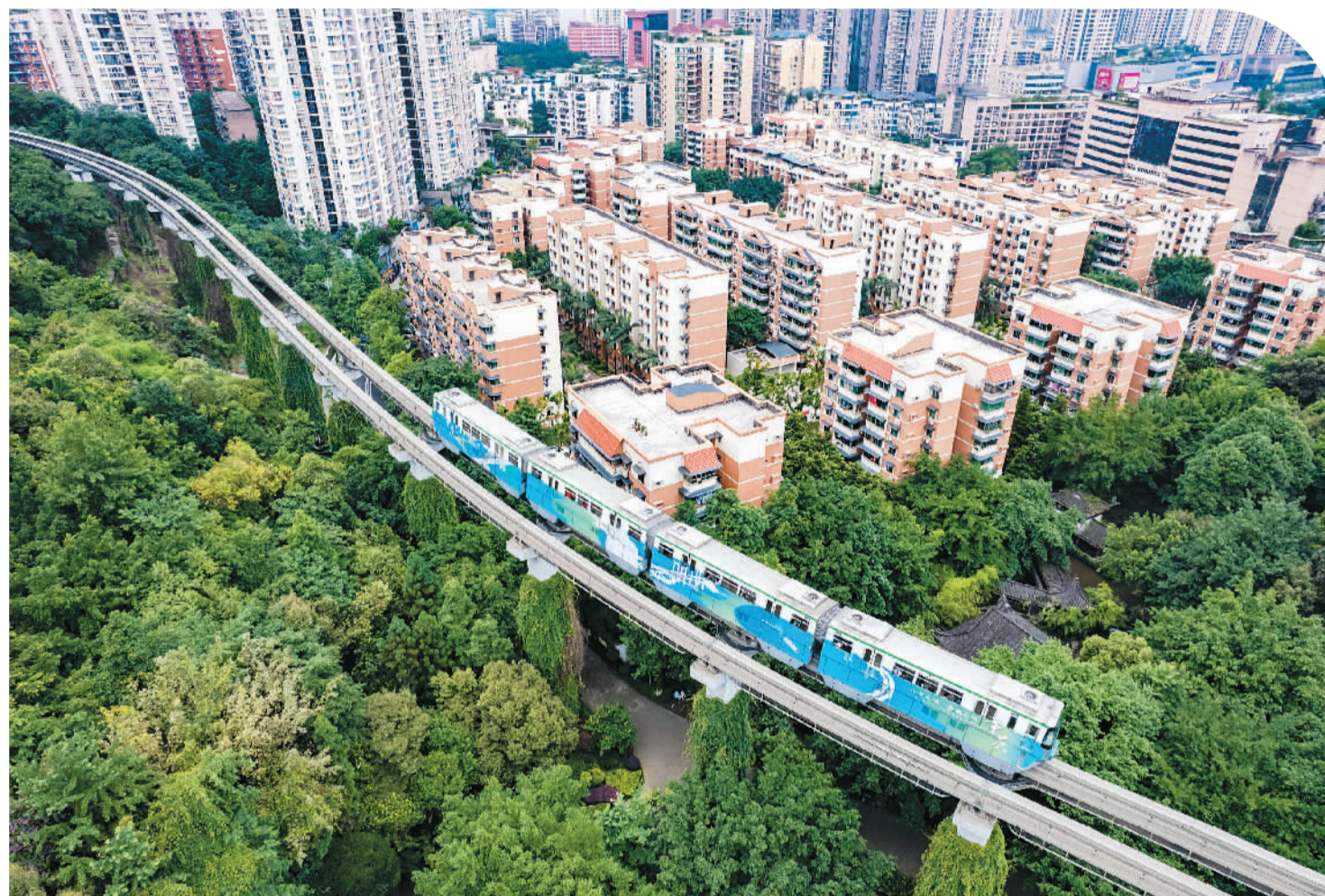
6月5日，重庆市大渡口区，完成房屋主体改造的月光片区老旧小区焕然一新。
