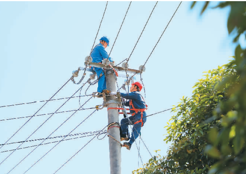
为保障“迎峰度夏”平稳用电，贵州省铜仁市供电部门近日积极组织电力工作人员开展农村电网巩固提升作业，通过巡视线路设备、改接负荷、智能监控等方式，强化农村电网运行管理水平，提升农村电网可靠供电能力。图为在铜仁市印江县新寨乡，南方电网铜仁印江供电局工作人员正冒着高温巡检线路。 向世杰摄（人民视觉）
