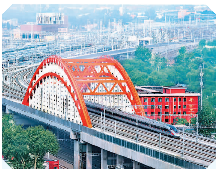
6月20日，G601列车作为北京丰台站驶出的第一列高铁列车行驶在丰台特大桥上。周宇杰摄（人民视觉）
