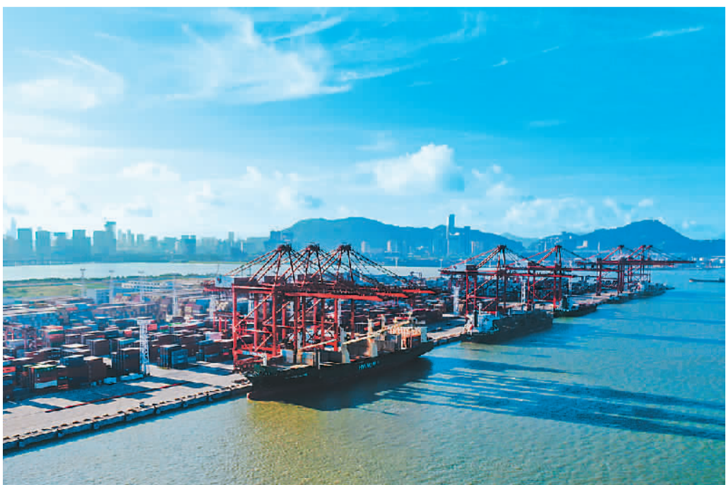
大铲湾码头位于广东省深圳市宝安区中心区，紧邻大铲湾片区及前海深港现代服务合作区，陆路可畅通无阻地往返珠三角制造基地，水路无缝连接珠三角西货源地。图为大铲湾码头一片忙碌景象。鲍贛生摄（人民视觉）
