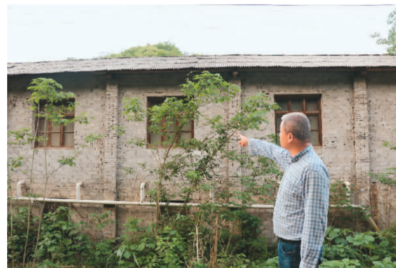
▲ 谢林港镇清溪村一处即将被拆除的猪舍。 新华社记者 丁春雨 摄
