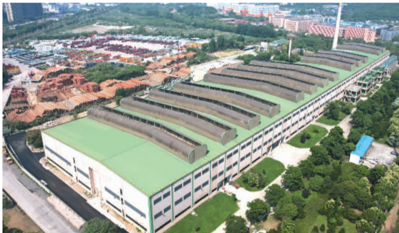
6月8日，从空中俯瞰浙江省杭州市杭钢云计算数据中心。
