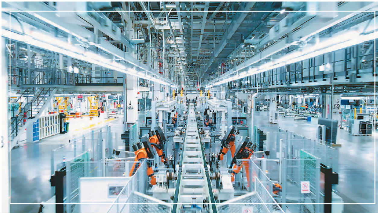
图为2021年12月21日，华晨宝马沈阳铁西新工厂进行设备安装和调试。
