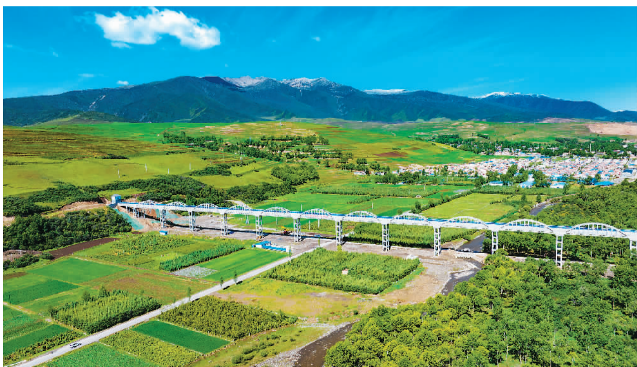
青海省引大济湟水利工程主体建设项目近日进入收官阶段。引大济湟工程从青海省东北部大通河调水引入湟水河，建成后将有效保障群众生产生活用水需求，助力青海生态保护和高质量发展。
