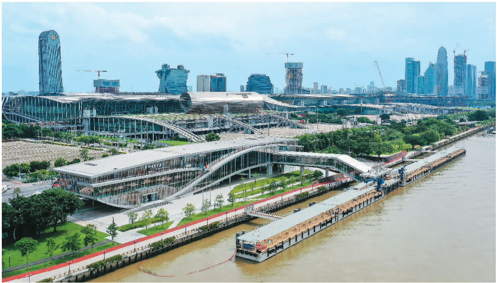
位于广东省广州市的琶洲港澳客运码头工程近日通过竣工验收,项目已建成5个客船泊位,首期投入2艘碳纤维高速客船,开通琶洲至香港国际机场及澳门市区航线,项目二期计划增开琶洲往返香港市区航线以及大湾区内地城市(深圳机场、珠海)之间水上客运航线,将填补广州中心城区到港澳水上高速客运航线的空白。图为航拍琶洲港澳口岸大楼及码头。
