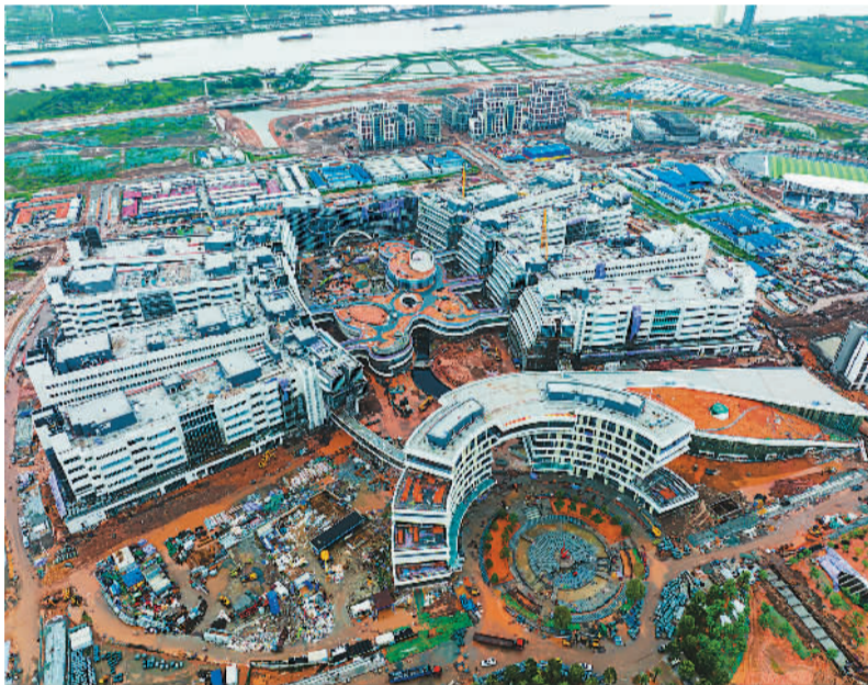
近日,位于广东省广州市南沙区的香港科技大学(广州)项目正紧张有序施工。香港科技大学(广州)项目是粤港澳大湾区建设的重点工程,建成后将成为促进粤港全面深入合作的科技创新平台和国际化人才培养基地。图为香港科技大学(广州)项目施工现场俯瞰图。
