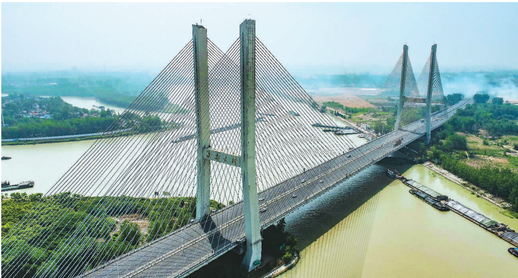
仲夏时节，江苏淮安，位于五河口（淮河、盐河、二河、京杭大运河、淮沐新河）交汇处的淮安大桥，与繁忙的京杭大运河相映成趣。图为京杭大运河繁忙的货船和行驶在淮安大桥的车辆。 赵启瑞摄（人民视觉）
