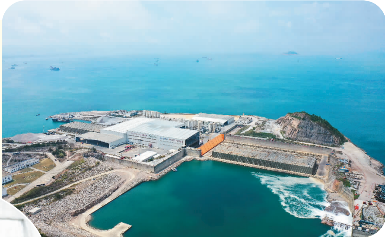
▲ 深中通道3节隧道沉管齐聚中交四航局牛头岛沉管智慧工厂。
