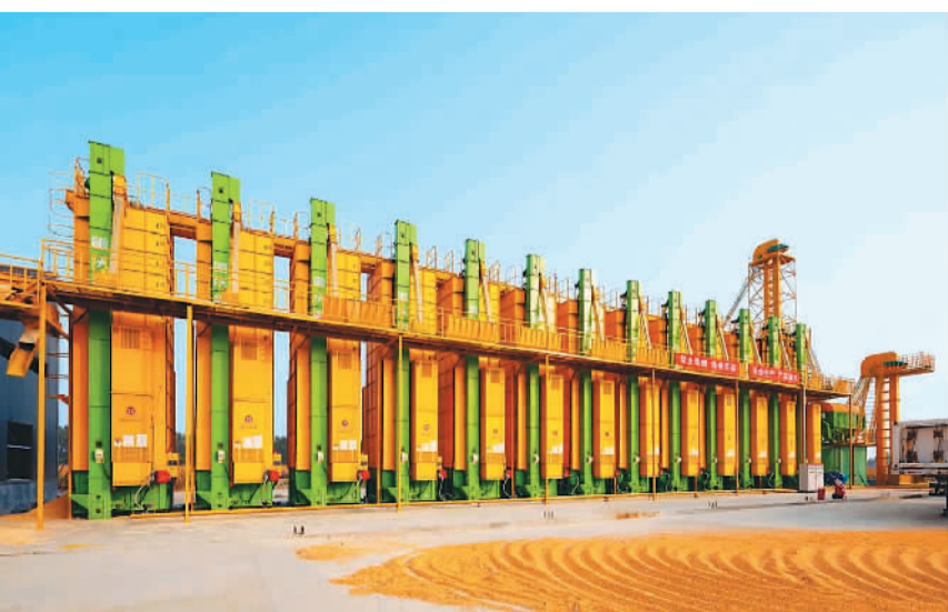
位于山东省德州市平原县的土地鲁望种养循环生态农场，运用现代农业机械设备进行小麦的田间管理和收割，确保夏粮丰收。图为该农场检修完毕准备运行的粮食烘干中心。张 硕摄
