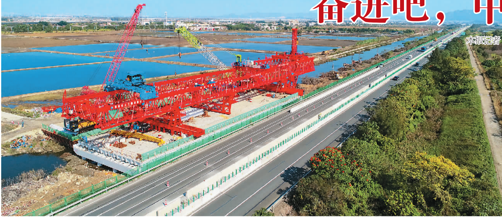
世界首台桩梁一体架桥机“共工号”。
