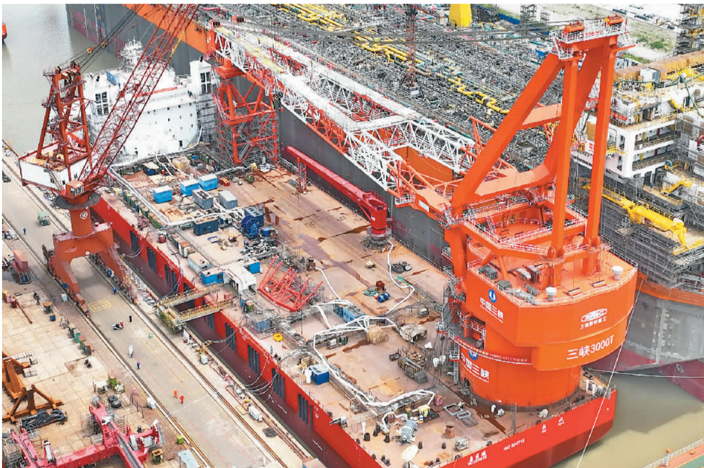
5月25日,在位于江苏省南通市海门区的招商工业海门基地,三峡集团3000吨全回转起重船顺利下水。该船是一艘集深远海风电基础运输和起重施工为一体的专业化风电施工船机。该船建成后,主要用于10兆瓦及以上机组的桩基基础施工,可装载3600千焦等级打桩设备进行施工作业。
