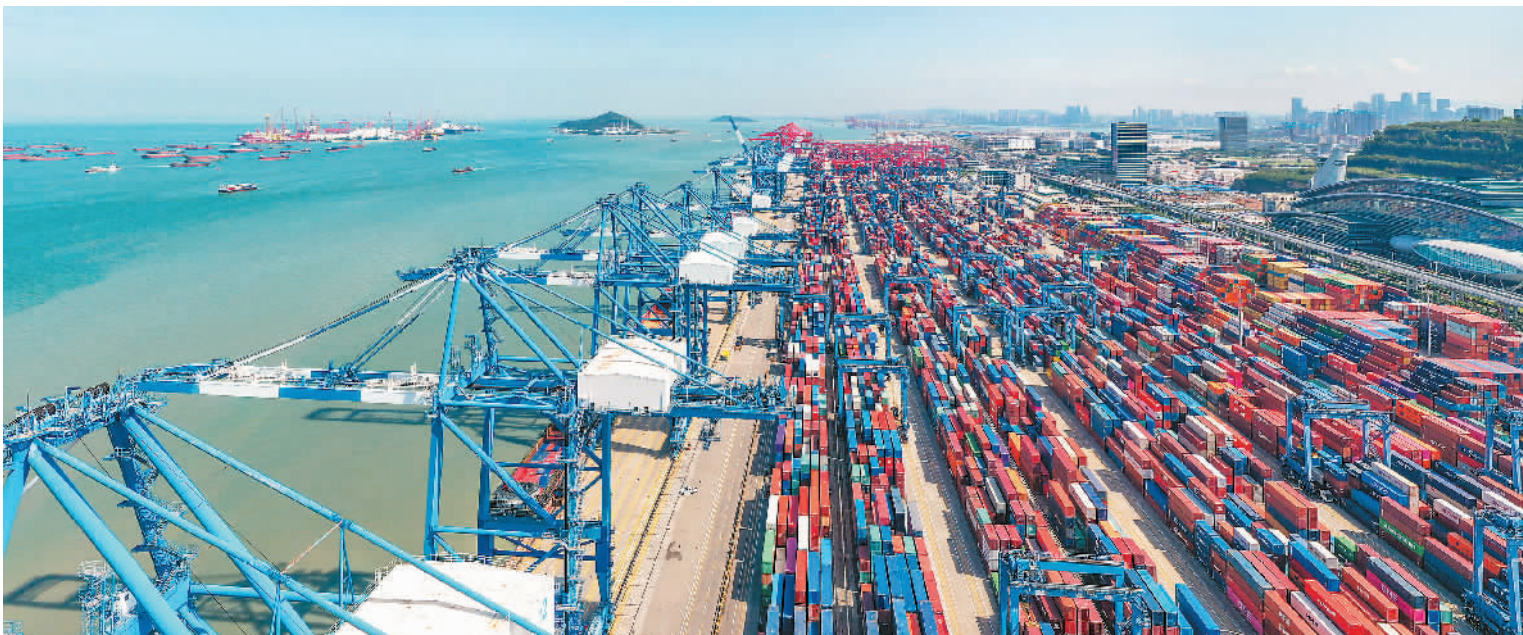
广东深圳妈湾智慧港是粤港澳大湾区建设的第一个5G绿色低碳智慧港口，是首个由传统散杂货码头升级改造并汇集自主知识产权和智能技术的智慧港。据测算，妈湾智慧港码头作业效率相比改造前大幅提升，碳排放量减少90%。
