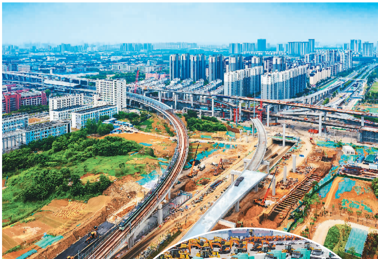
▲5月14日，在安徽省合肥市文忠路高架项目现场，施工人员正在进行主线桥最后一联现浇混凝土浇筑，标志着合肥首个双层高架桥建设取得新进展。
