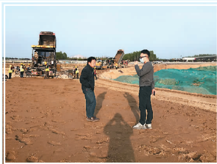
刘泽坤（右）在项目施工现场。（受访者供图）
