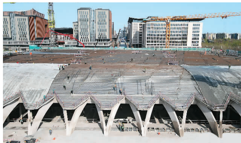
4月6日，正在加紧建设的河北省雄安新区计算（超算云）中心。
