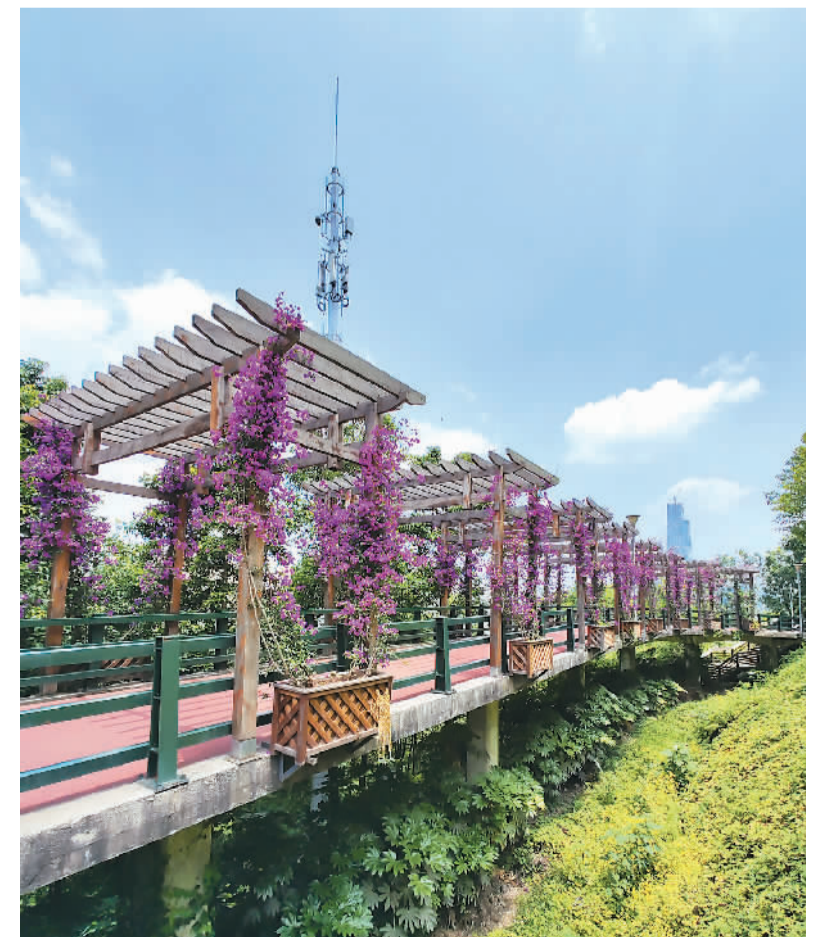
近年来，重庆市将山城步道和公园建设与老旧小区改造相融合，既改善了人居环境，又催生了文旅经济新业态。重庆市在中心城区规划建设“街巷、滨江、山林”等类型山城步道17条、约353公里，目前已有10条、约300公里完工。图为日前，重庆市渝中区龙头岩公园内的山城步道两侧，三角梅花开得正艳。 李洪波摄(人民视觉)
