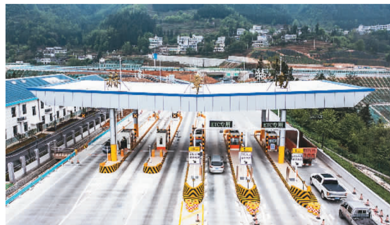
4月22日，由贵州交建集团承建的赫（赫章）六（六盘水）高速公路正式建成通车。 新华社记者 陶亮摄
