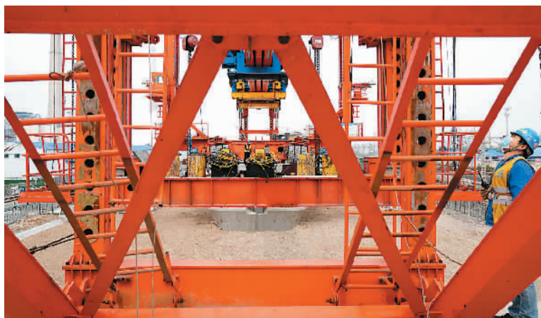
4月30日，山东省济南市黄台联络线施工现场，中铁十局的工作人员在进行双线路架梁作业。 新华社记者 郭绪雷摄
