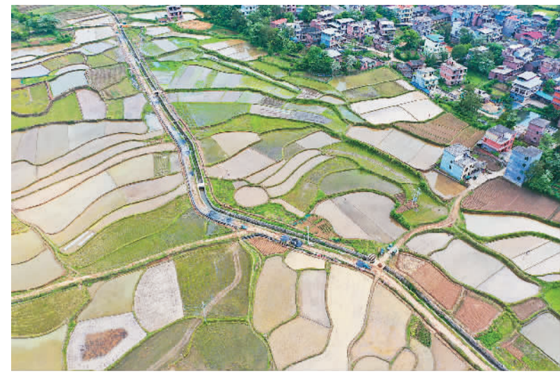
春耕时节，各地新修节水渠、改造陈旧老渠，保障农田灌溉用水。图为日前，湖南省永州市道县白马渡镇樟武坊村，当地正在整修农田灌溉水渠。何红福摄(人民视觉)
