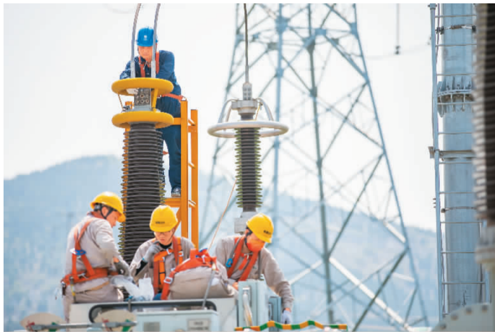
▲ 4月22日，电力施工人员在安徽省淮北市开渠220千伏变电站，对电网设备开展技术改造、综合检修消缺等作业，确保迎峰度夏期间能源可靠供给。 王文 朱思杰摄影报道
