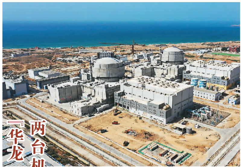
图为“华龙一号”海外首个工程——巴基斯坦卡拉奇核能2、3号机组。王进杰摄
