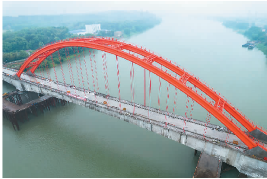
4月15日，由中铁五局承建的常(德)益(阳)长(沙)铁路控制性工程——资水特大桥建设竣工，为常益长铁路早日通车奠定基础。常益长铁路线路全长约157公里，设计时速350公里，是国家“八纵八横”高速铁路网的重要组成部分。图为资水特大桥。新华社记者 陈思汗摄
