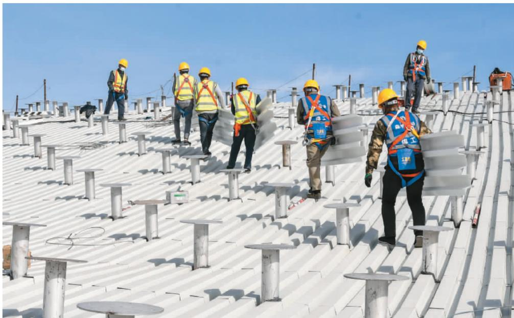
4月13日，新疆乌鲁木齐机场改扩建项目T4航站楼工程钢屋盖全面提升并拼接完成，实现封顶，标志着T4航站楼整体框架施工完毕，进入金属屋面及幕墙安装阶段。作为国家“十四五”期间重点工程项目，乌鲁木齐机场改扩建工程目前稳步推进，航站楼工程已完成基础施工、主体结构封顶、钢结构合龙等多个关键节点。图为施工人员在安装航站楼屋面板。
