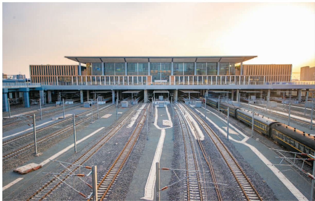
4月12日,北京丰台站站房工程全部完工,标志着该站已具备开通条件。北京丰台站是中国首座采用高速、普速重叠的双层高架车场的大型客运站。年内开通运营后,将承担京广高铁、京港城际、京九客专以及丰沙、京原、京沪线及市郊铁路的始发终到作业,与北京站、北京西站、北京南站、北京北站等北京铁路枢纽深度融合,进一步优化首都交通运输结构,完善首都综合交通体系。图为北京丰台站站房全景。
