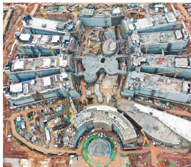
连日来,广东省广州市南沙区东涌镇香港科技大学(广州)校区施工现场一派繁忙。工人们全力以赴加快施工进度,确保校区按期完工交付使用。图为港科大(广州)校区施工现场。 王国荣摄(人民视觉)
