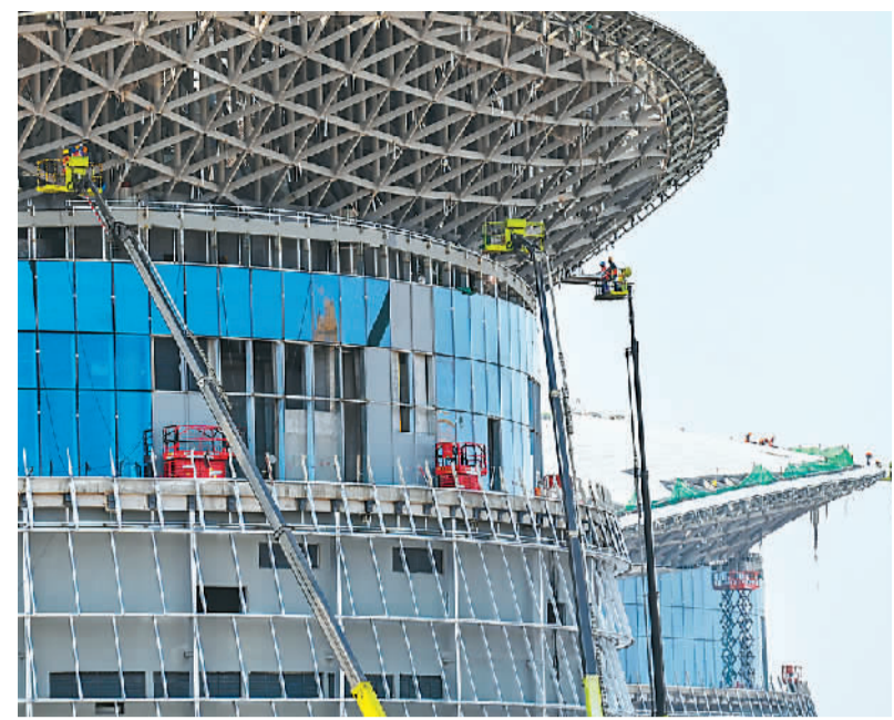
海南省海口市国际免税城项目规划占地面积675亩，总建筑面积约为92.6万平方米，是集免税、办公、公寓、休闲、文旅为一体的世界级度假型商业街区，建成后将成为海口新地标，国际旅游消费中心的新名片。目前，该项目免税商业中心造型屋面已顺利合拢，预计今年正式投入使用。图为4月6日，工人正在进行外立面幕墙施工。石中华摄（人民视觉）
