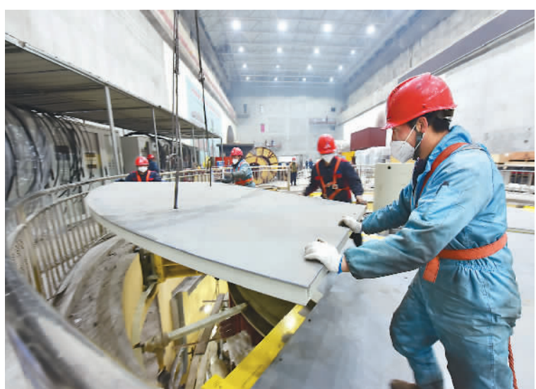
黑龙江省荒沟电站位于黑龙江省海林市境内，是黑龙江省首座大型抽水蓄能电站，电站总装机容量120万千瓦。目前，1号、2号机组已经实现并网发电，计划9月底前4台机组全部投产发电。图为工程技术人员正在进行4号机组盖板的吊装。张春祥摄（人民视觉）
