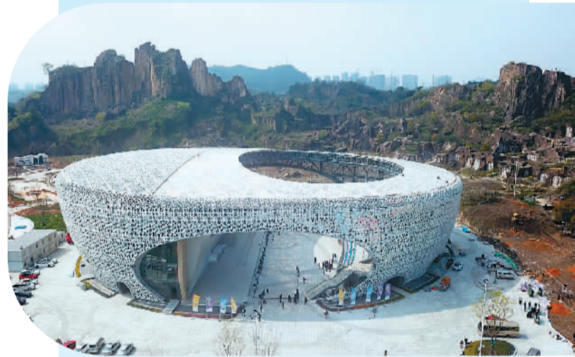
绍兴柯桥羊山攀岩中心
