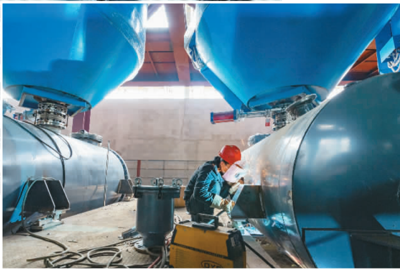
▶4月1日,工人在工地忙着焊接反应釜支架。
