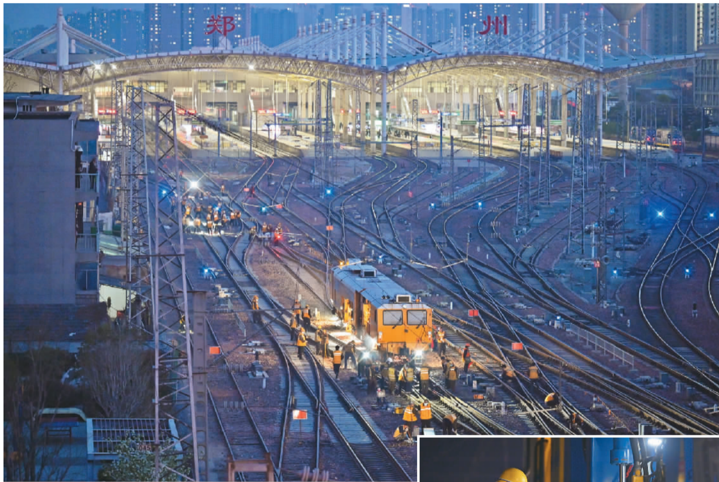
4月2日，郑州站大型养路机械车数字化捣固作业现场，施工人员正在配合机械车开展道岔精调。
