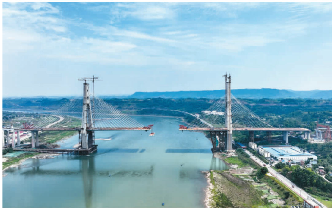
4月3日，四川宜宾临港公铁两用长江大桥正在进行中跨梁段钢箱梁吊装。宜宾临港公铁两用长江大桥是新建川南城际铁路自贡至宜宾线的重点控制性工程，是国家“八纵八横”中渝昆高铁、蓉昆高铁的共同过长江通道。
